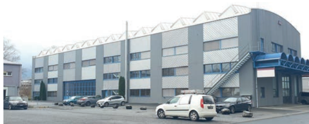
Neue Räumlichkeiten im ehemaligen «Factory Loft» im obersten Stockwerk.
